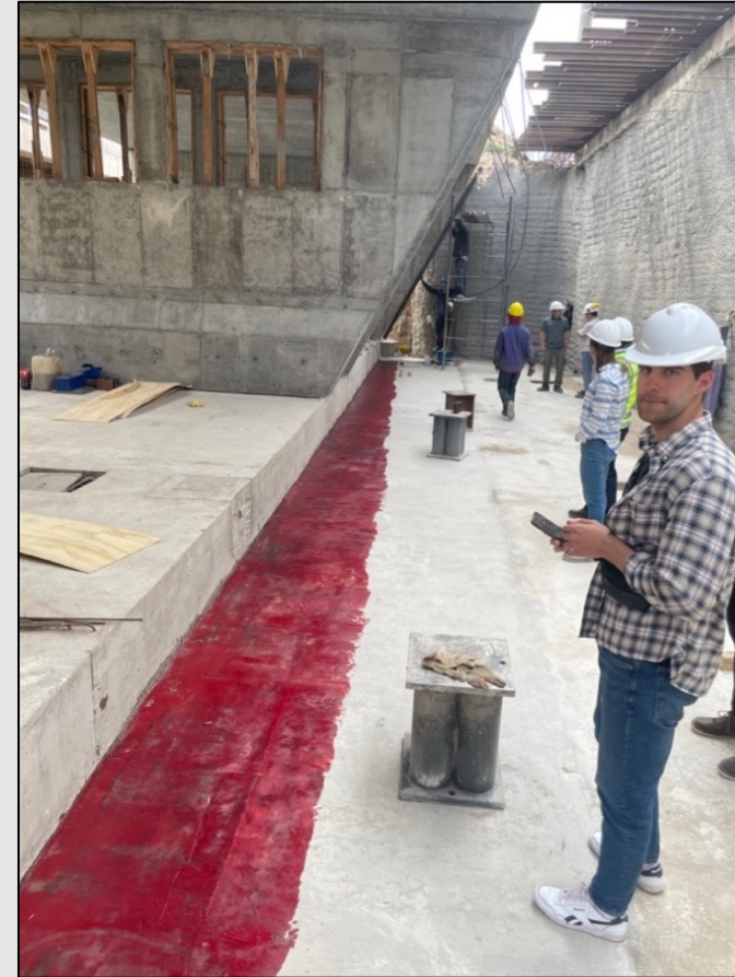
Capa de grasa para deslizar/Fettschicht zum Rutschen
