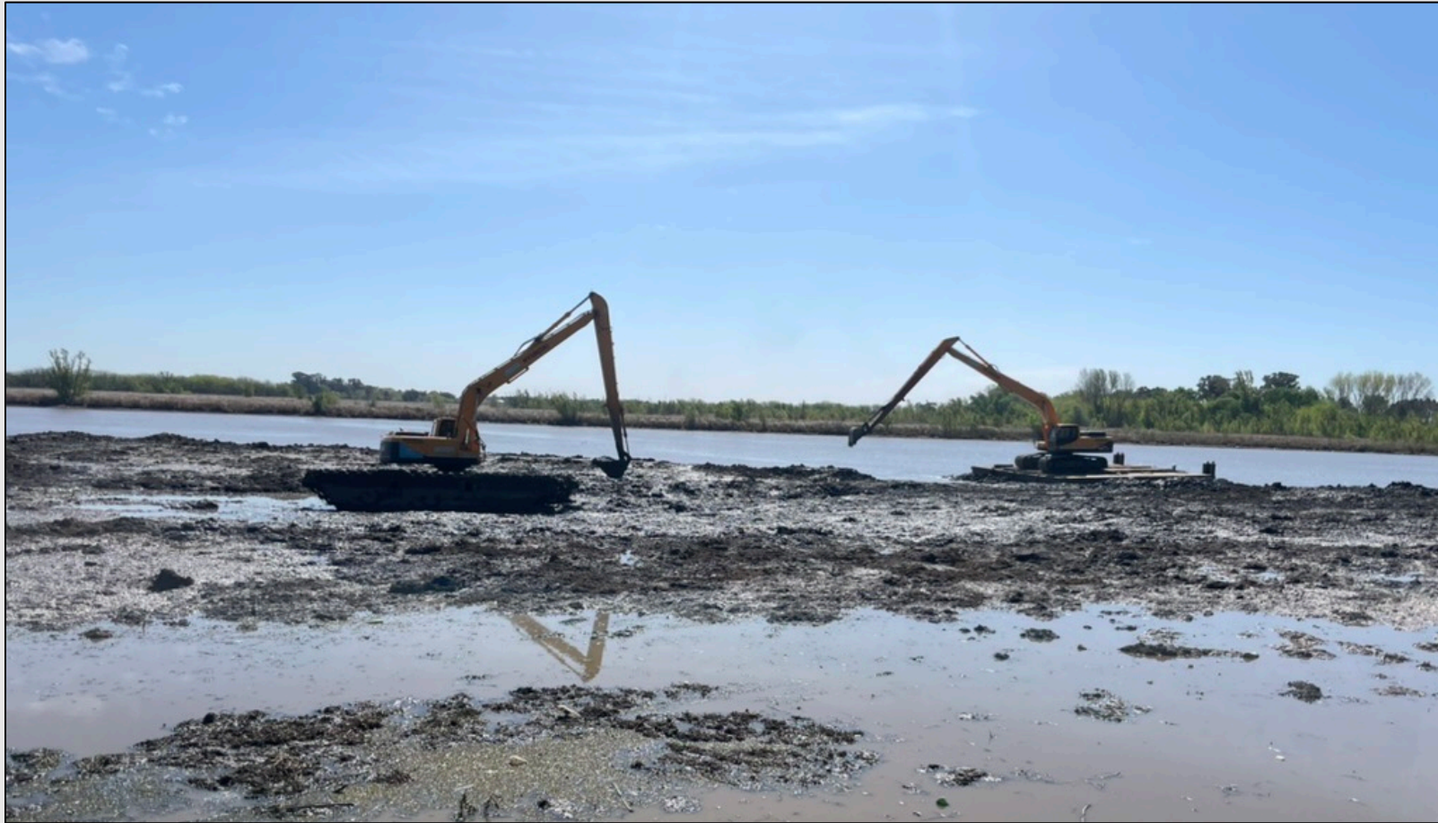
Dragado del camalote/Ausbaggerung der Schwimmpflanze
