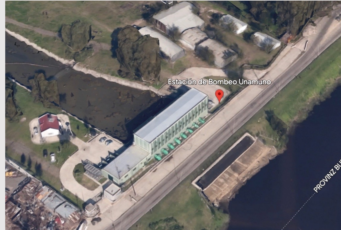
Estación de Bombeo del Arroyo Unamuno/Pumpstation Unamuno
