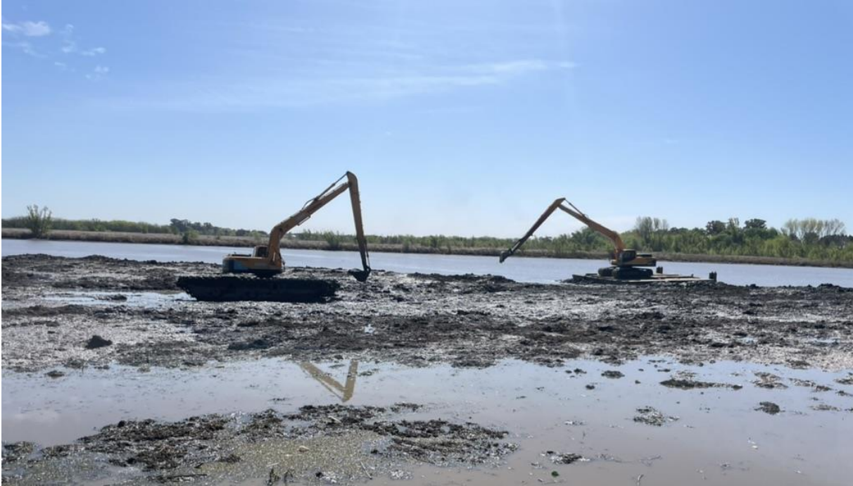
Figura 16 - Retirada mecánica del camalote con excavadoras
