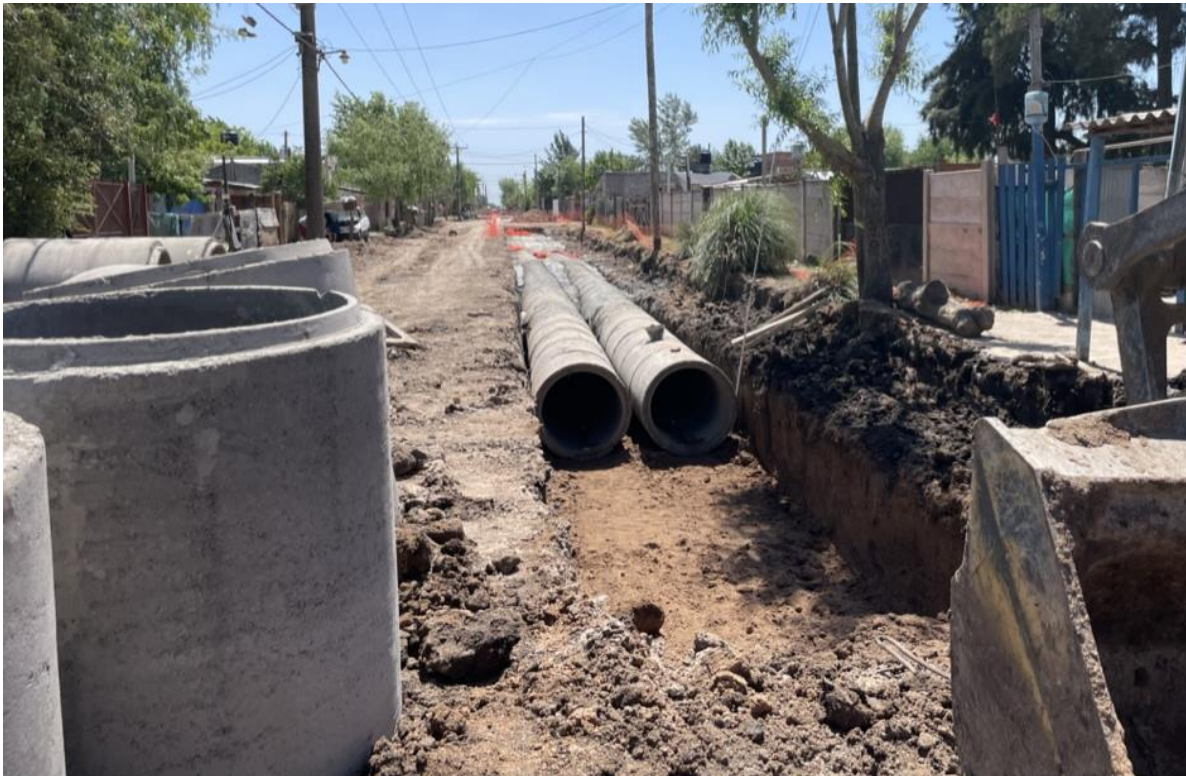
Figura 10 - Construcción de cañería
